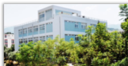
Κτήριο Επέκτασης Τμήματος Χημικών Μηχανικών
