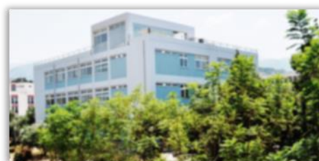
Κτήριο Επέκτασης Τμήματος Χημικών Μηχανικών
